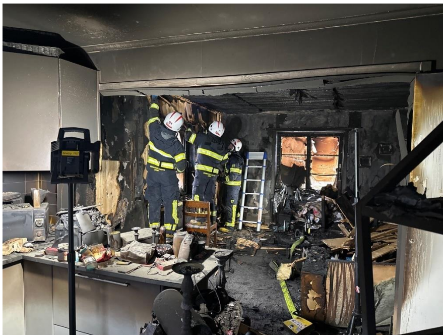
Figur 4. Kök och vardagsrum.
