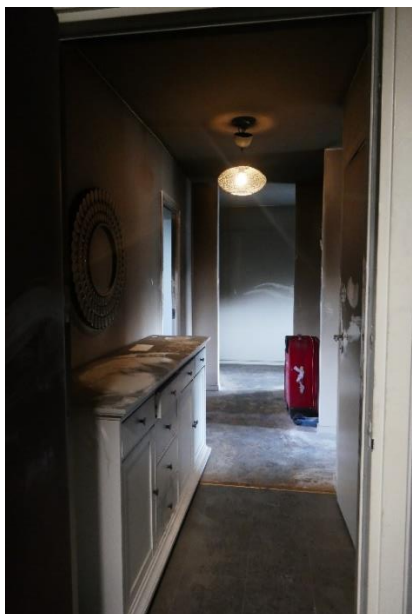
Figur 3 visar vy in i lägenheten från dörren till trapphuset
