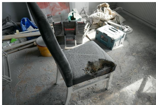
Figur 6 brandskada på stol
