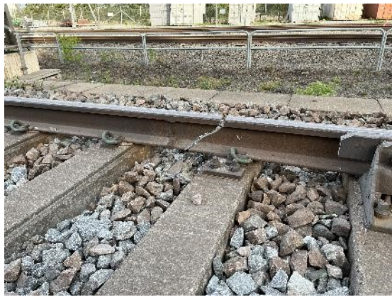
Figur 15 Krafterna från urspårningen knäckte och böjde rälsen på flera ställen, vissa helt av och andra med tydliga skador.
