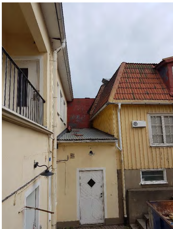
Figur 5 Baksida brandvägg med fasad utförd i oskyddad träpanel
