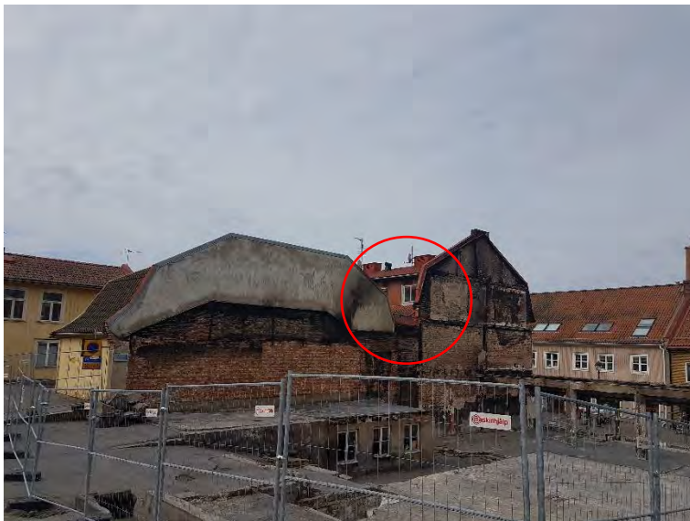
Figur 4 Nedsänkning i brandmur
