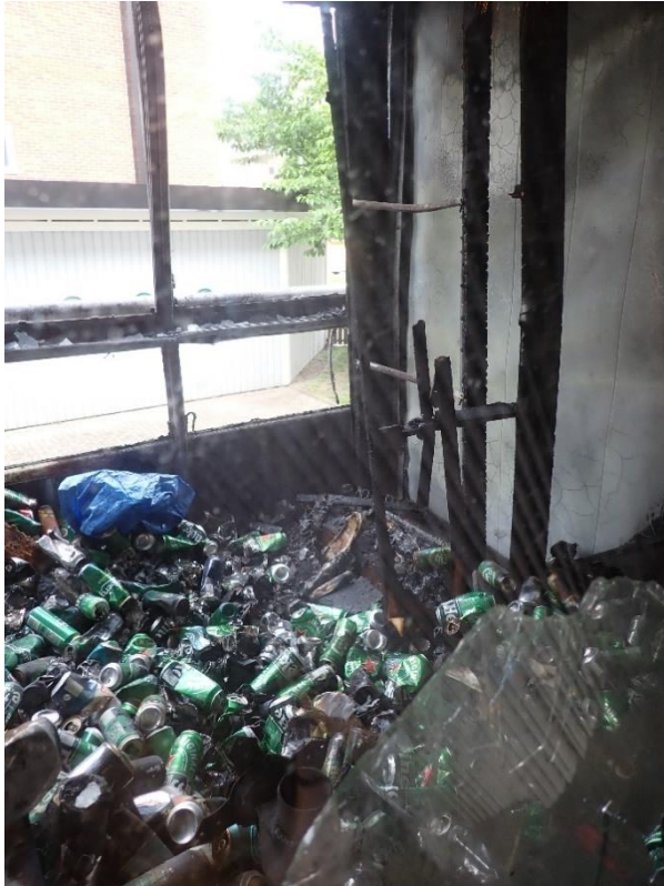
Figur 7 Foto på balkong med hög brandbelastning. Foto Sebastian Levin Sbff
