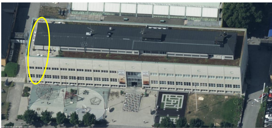
Figur 1. Bild av tekniska museets entrébyggnad (från öster). Huvudentré i mitten av byggnaden. Del av byggnaden i markplan där branden inträffade, gul markering. Bildkälla Helios.
