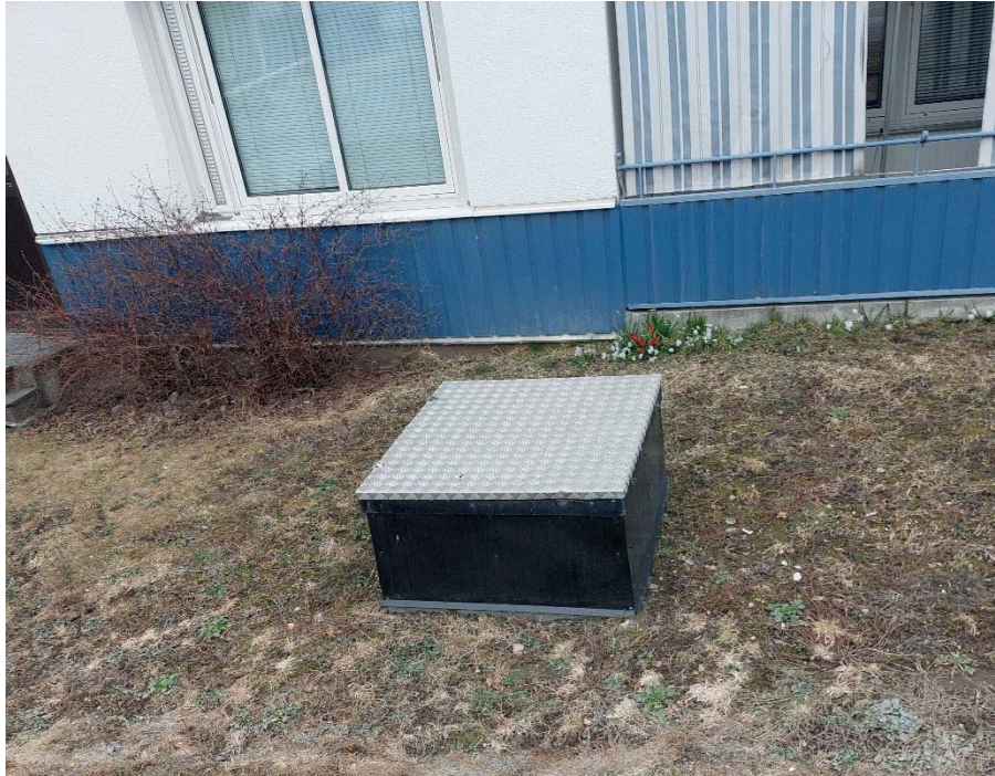
Figur 7 Röklucka till källare, foto från platsbesök 20220413
