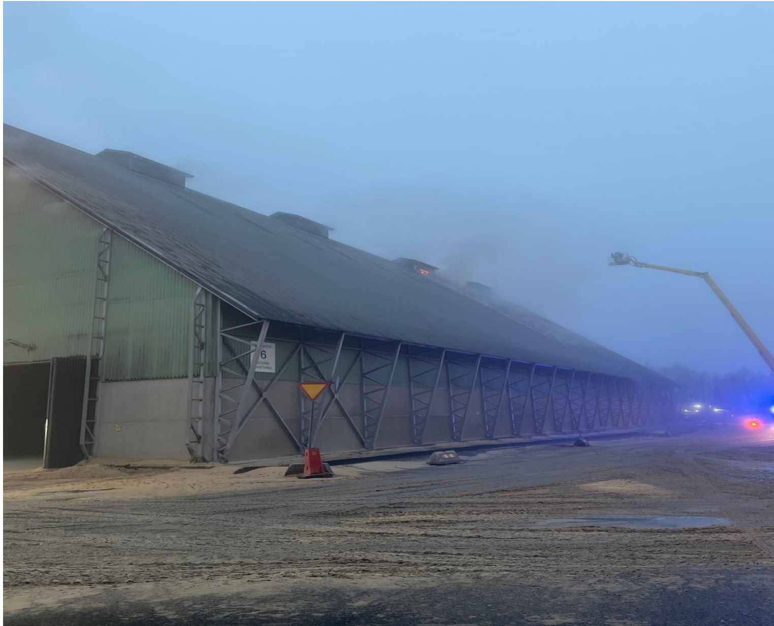
15:41 Höjdfordon användes för att komma åt att släcka takkuporna
