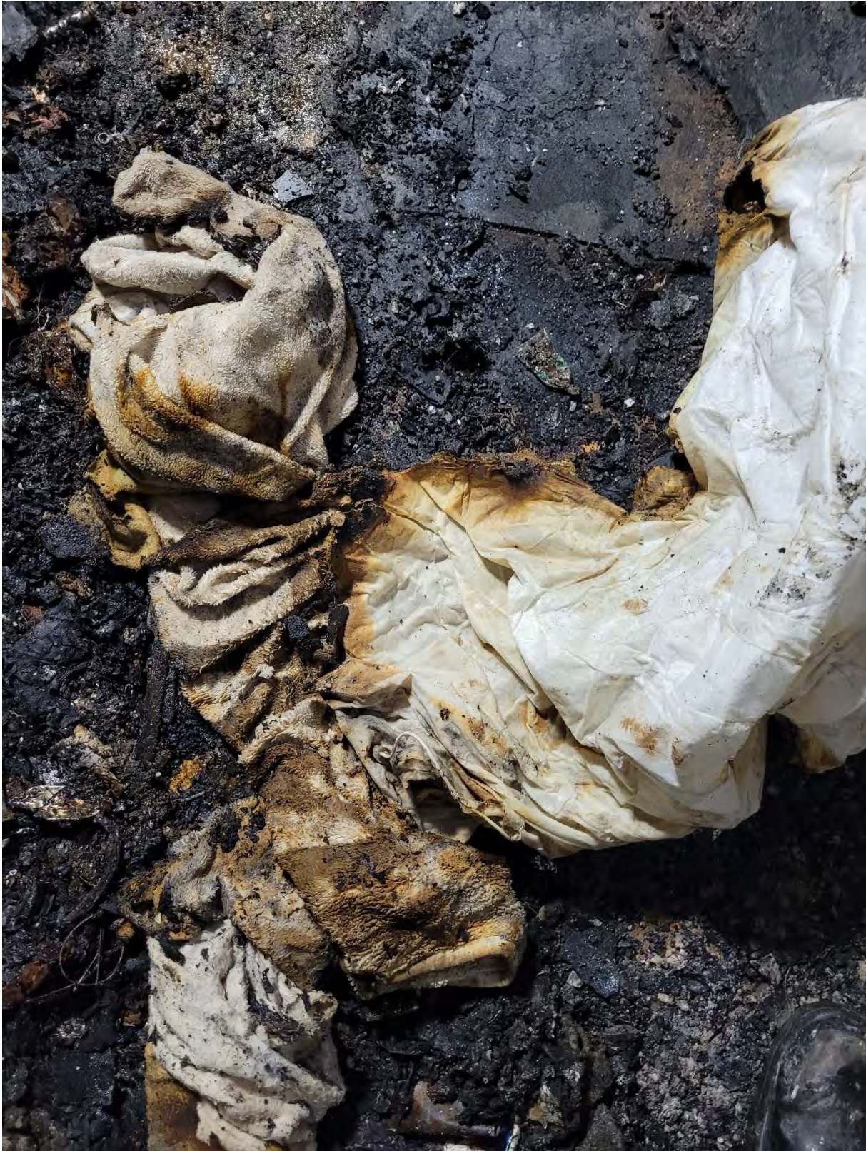
Figur 10. Bild på resterna från en värmefilt som återfanns precis intill bäddsoffan. Eftersom filten är så skadad är det svårt att fastställa med säkerhet att den orsakat branden.
