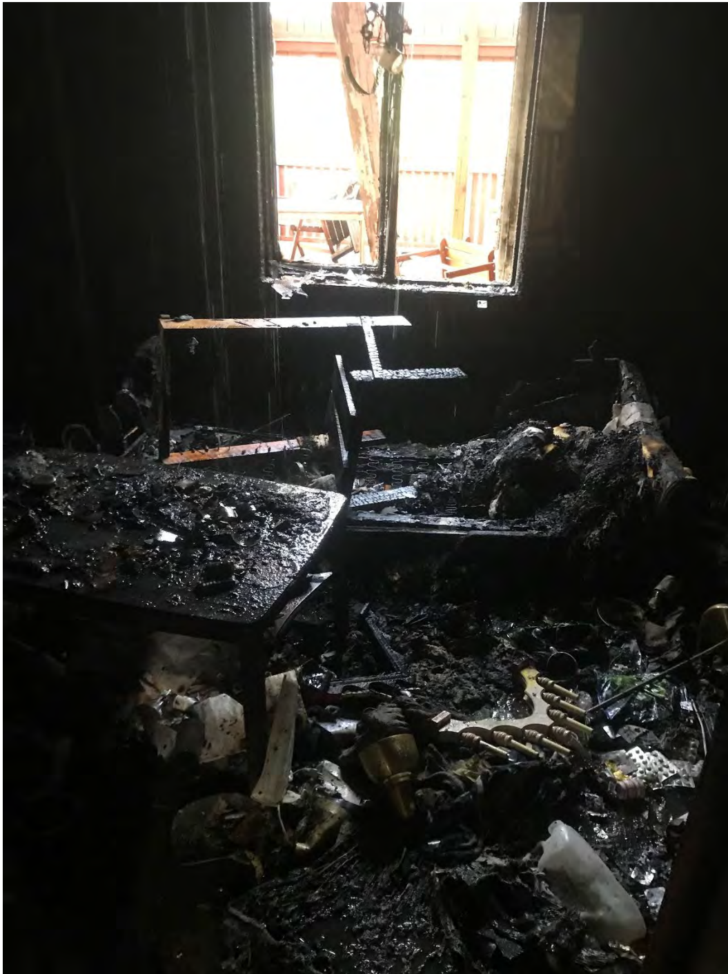
Figur 5. Bild på brandrummet och fönster mot altanen. Brandrester från bäddsoffan syns på golvet nedanför fönstret. Bilden är tagen av insatspersonal under insatsen innan material flyttats för eftersläckning.
