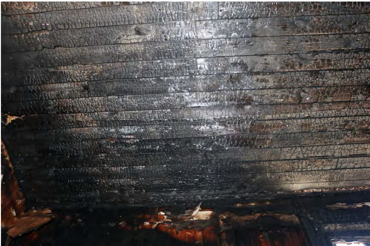
Figur 13 - Tak ovanför bedömt primärbrandområde (hörnet med skrivbordet). Foto från Polisen.
