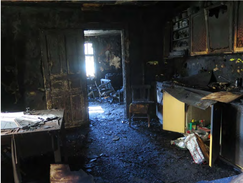
Figur 5 - Foto taget genom köksfönster baksida. Bortanför köket finns sovrummet där brand bedöms ha uppkommit. Dörr mellan kök och sovrum bedöms ha varit öppen under stora delar av brandförloppet.
