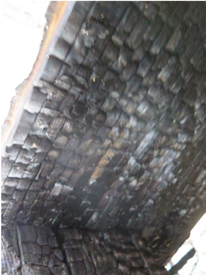
Figur 11 – Närbild undersida skrivbordsskiva mot låddel (hurts). Kraftiga brandskador.
