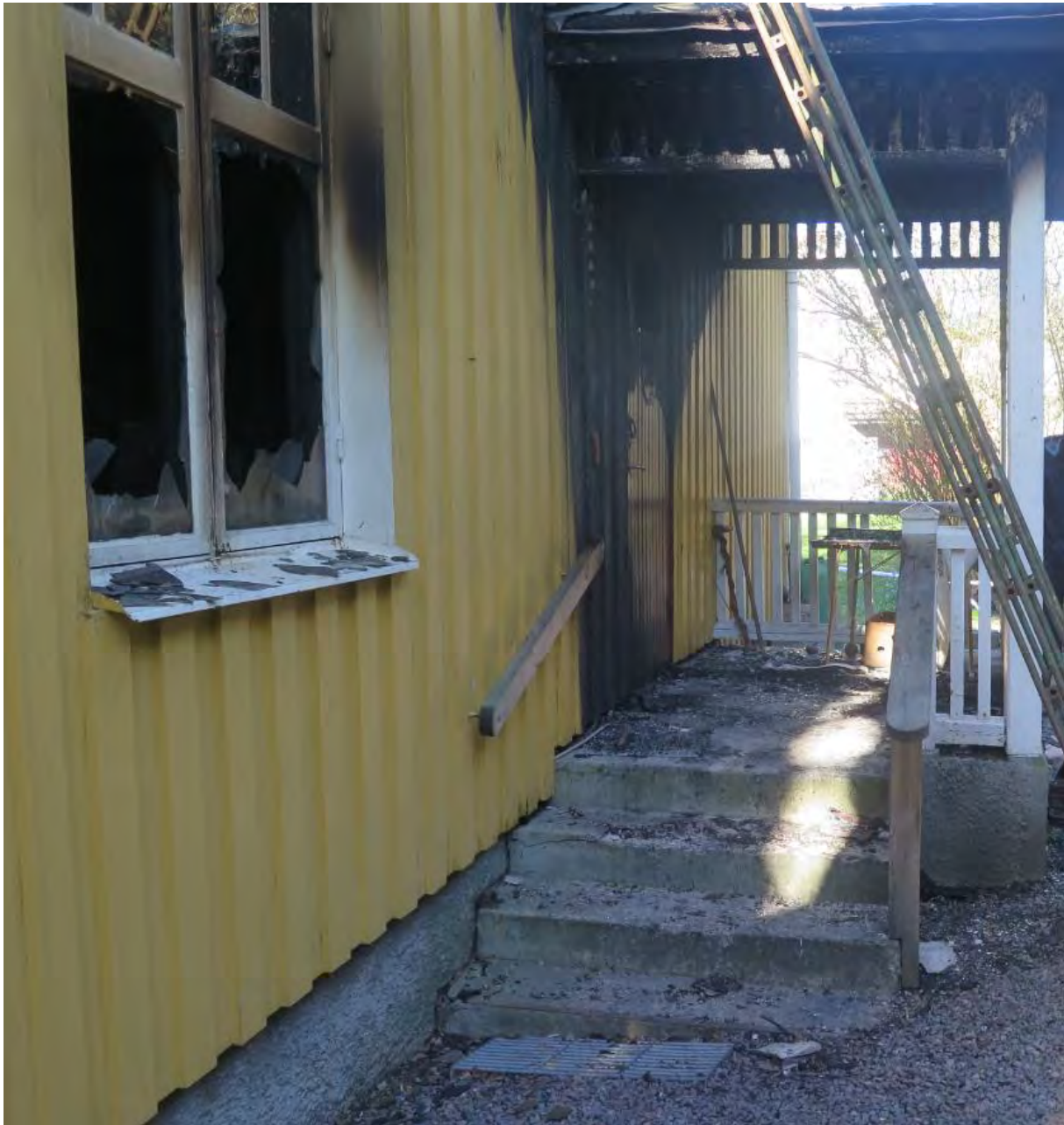
Figur 3 - Baksidan av huset. Köksfönster har gått sönder av värmepåverkan. Det har brunnit kraftigt genom ytterdörr (brandmönster visar att ytterdörr har varit öppen under del av brandförloppet, bekräftas även av uppgifter från hemtjänst och räddningstjänst).
