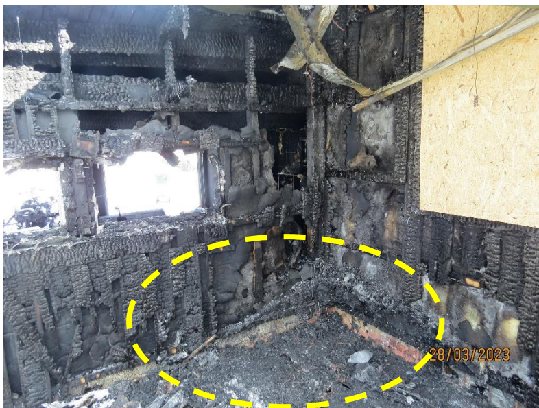
Bild 2: Gula cirkeln visar primära brandstartsområdet. I det primära brandstartsområdet ligger resterna av kablar som kommer från solcellspanelerna.
