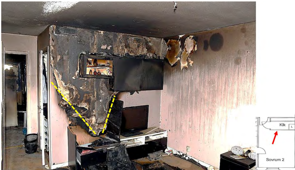
Bild 4. Bild tagen från polisens protokoll över brandplatsundersökning. Visar en av de två brandhärdarna.
