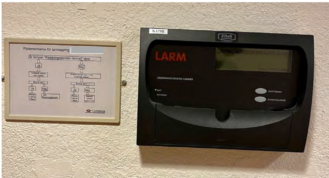
Figur 4. Larmlagringstablå som är placerad i korridor på varje avdelning.
