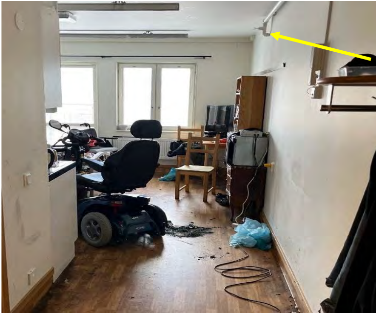
Figur 2. Bild från brandrummet, sprinkler som löste ut är markerad.
