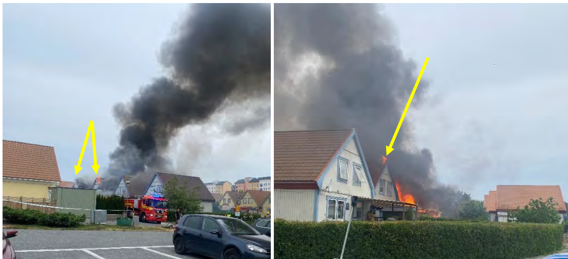
Figur 3. Bild 1. Kedjehusens framsida klockan 17:13. Skadeutbredningen till kedjehus ■ 3 och ■ 5 med brand i kallvindarna markerade. Bild 2 Kedjehusens baksida klockan 17:13. Kraftig brandpåverkan på byggandenas utsida samt brandgenombrott i krypvinden till kedjehus ■ 7 markerad. Bilder tagna av insatspersonal 2023-06-17.
