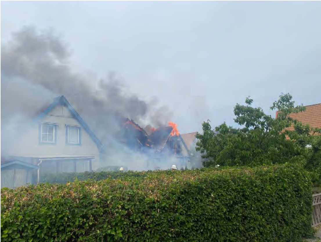
Figur 6. Byggnadens baksida klockan 17:22. Från vänster i bild ■ 7, ■ 5 och ■ 3. Skadeutbredningen stor på fasad, i byggnaderna och uteplatser ■ 5 och ■ 3. Branden har spridit sig till krypvind till ■ 7. Foto tagen av insatspersonal 2023-06-17.
