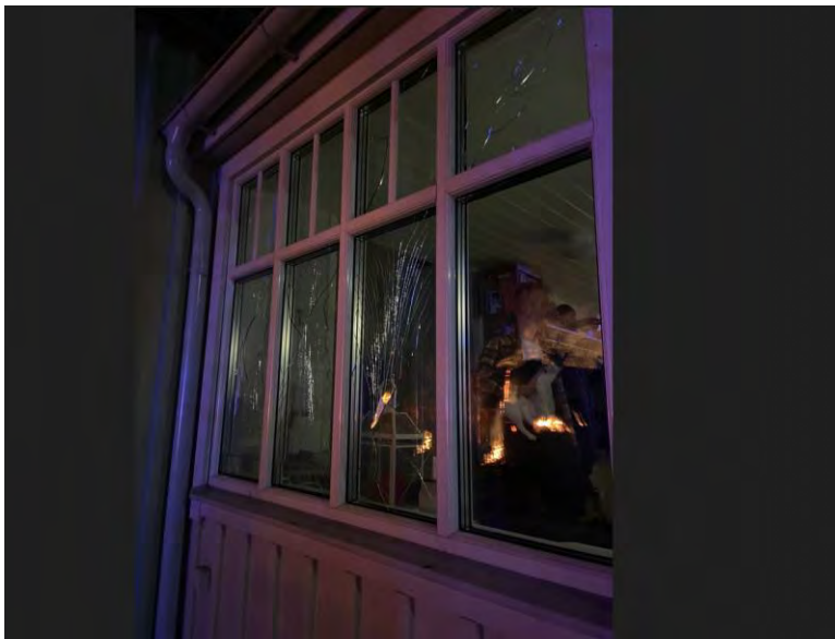
Bild 5. Grannhusets fönster som sprack på grund av strålningsvärmen från branden.
