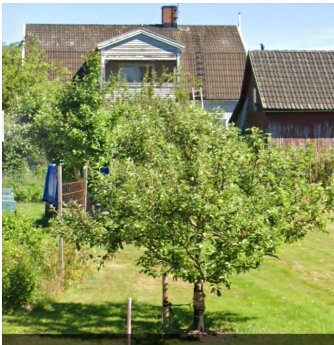
Bild 6. Inbyggd balkong på baksidan huset.
