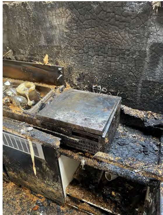
Bild på kylaggregat (avläggingsyta)
