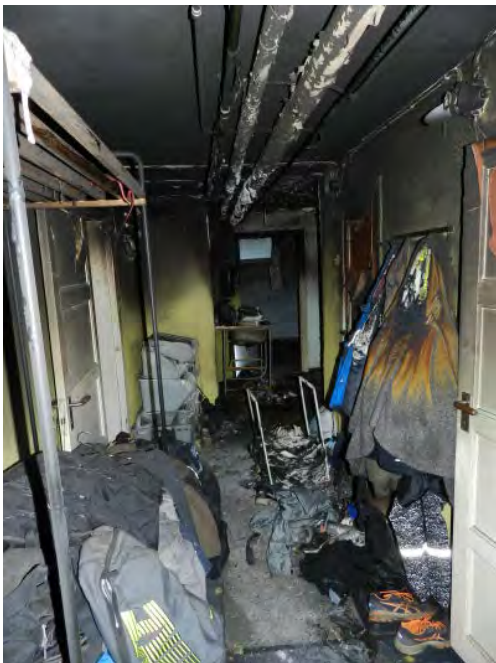
Vy från garaget mot primärbrandplatsen.
