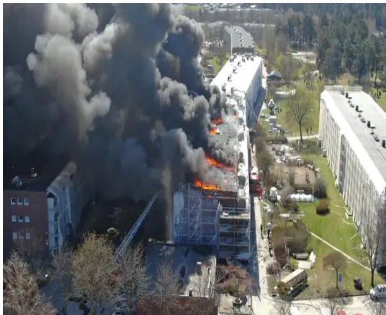
Figur 1. Bild tagen med drönare från ledningsplats
