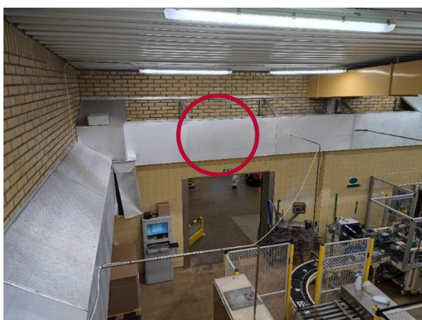
Figur 6 - Röd markering visar ungefärlig placering för läckaget.
