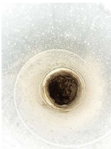
Figur 7. Bild i ventilationskanalen i köket.
