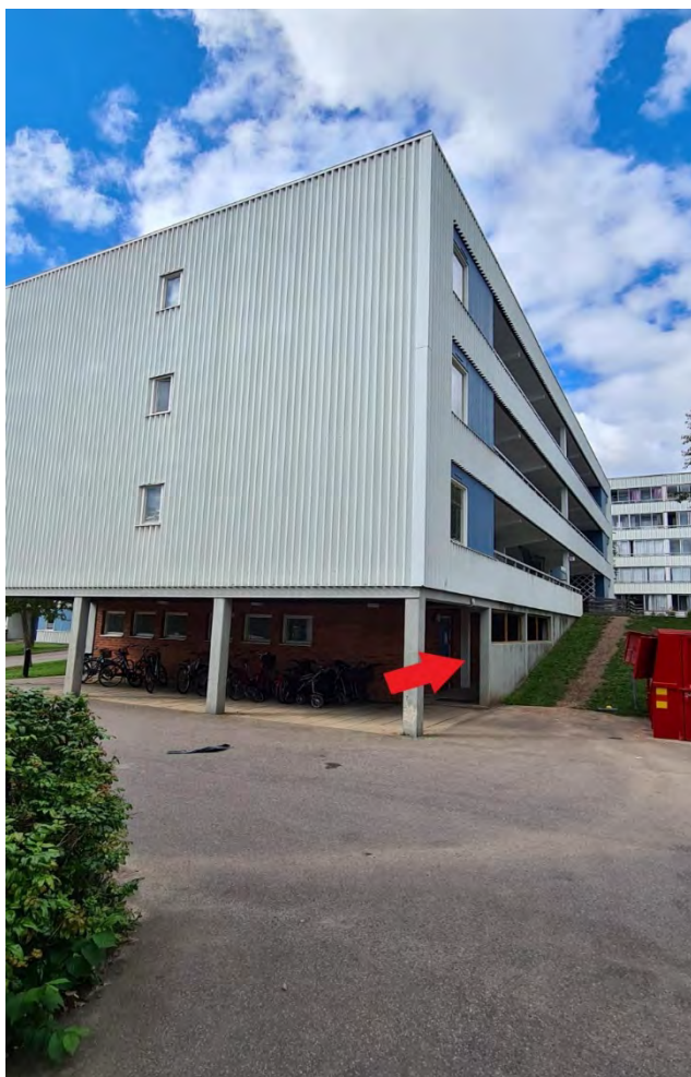
Bild 2: Röd pil visar gången in mot angreppsväg/baspunkt där en dörr behövde brytas.
