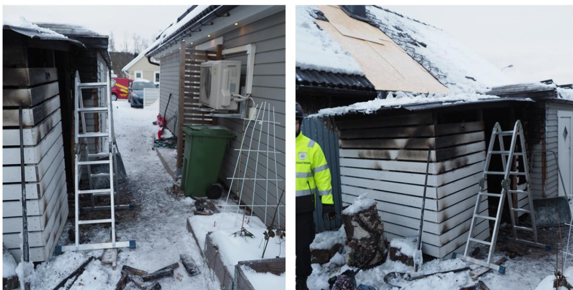
Bild 2 Bilderna tagna från baksidan ut mot vägen. Visar avståndet mellan garage och hus. Bilden till höger visar hur garaget är vidbyggt med grannens bostadshus.
