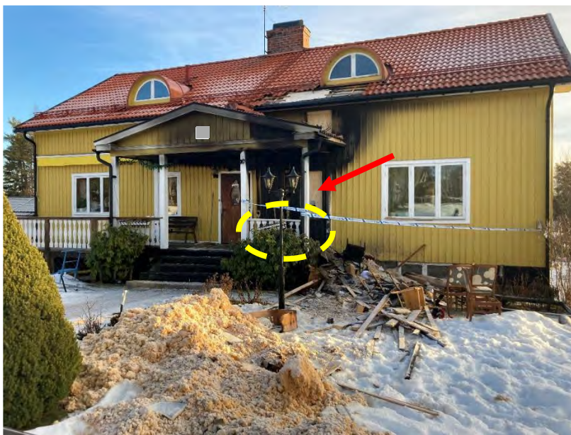
Bild 1: Gula cirkeln visar primära brandstartsområdet. Röda pilen visar fönstret som branden spridit sig in i byggnaden genom.
