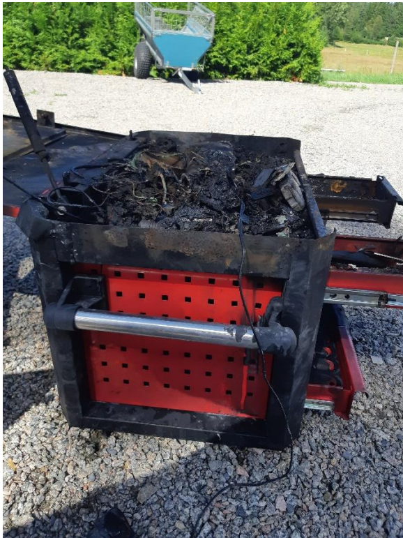
Bild 3. Verktgsskåpets övre del.
