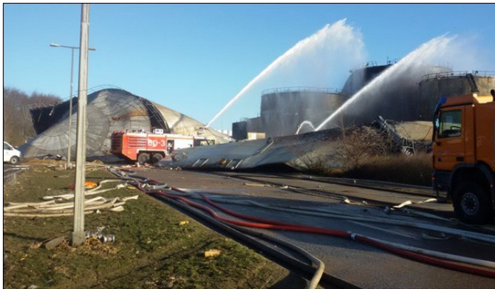
Dagen efterbranden i Fredericia. Den kollapsade ureacisternen ligger till vänster i bild.
