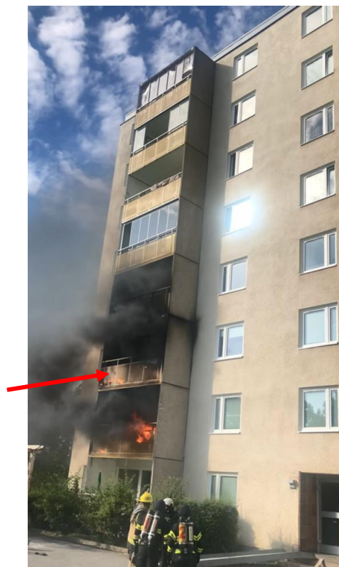
Bild 2. Branden har spridit sig från startbrandplatsen på balkongen på 2:a våningen (där pilen pekar) till balkongen under på 1:a våningen
