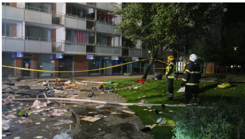
Figur 18, Förödelsen nedanför, resultat av explosionen som kastade ut saker från lägenheten.
