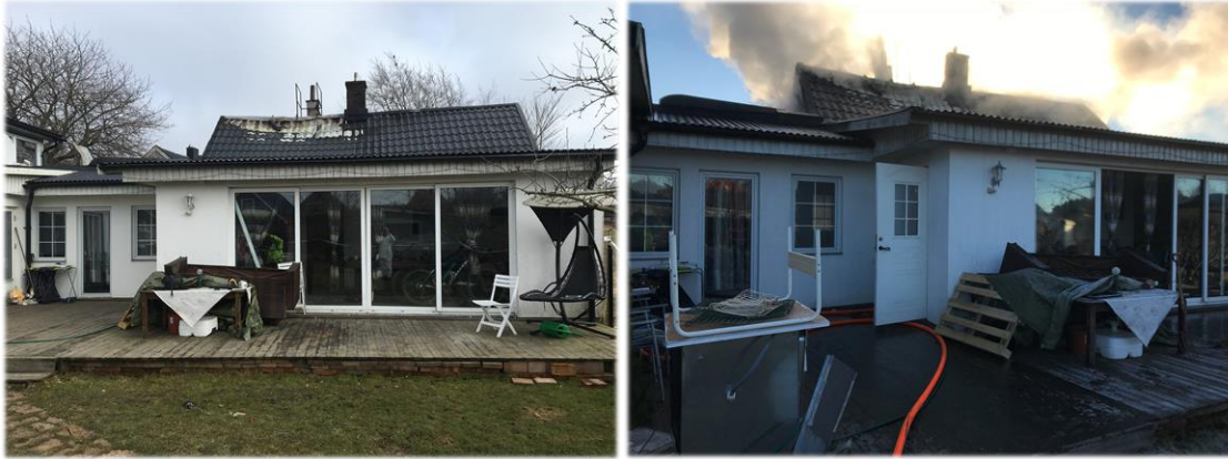
Figur 3 och 4, Annexet (tillbyggda delen av bostadsbyggnaden)
