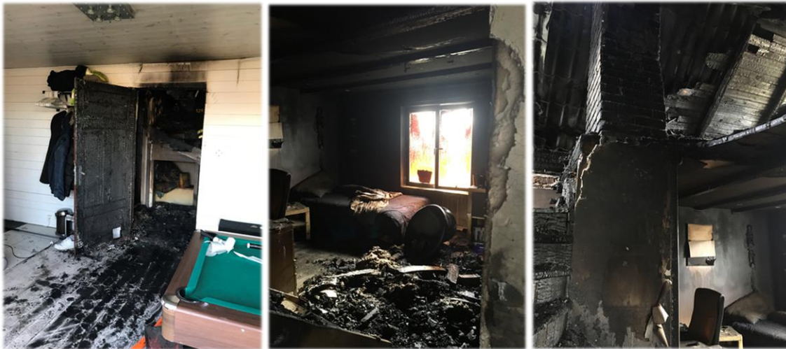
Figur 5, 6 och 7, Dörr in till bostad, säng i vardagsrum, trappa upp till ovanvåning/loft.
