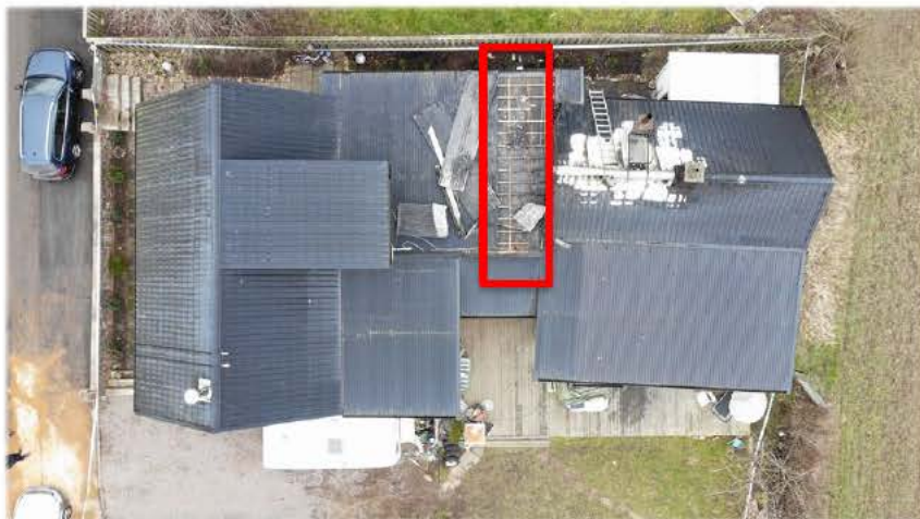
Figur 12, Olika åtgärder från räddningstjänsten, friläggning av plåt mitt på byggnaden.
