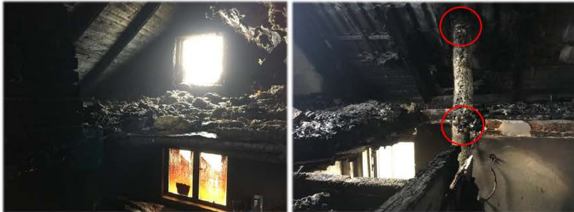
Figur 8 och 9, Bild mot höger, bild mot vänster/ rakt fram (tagen när man står i trappan upp).
