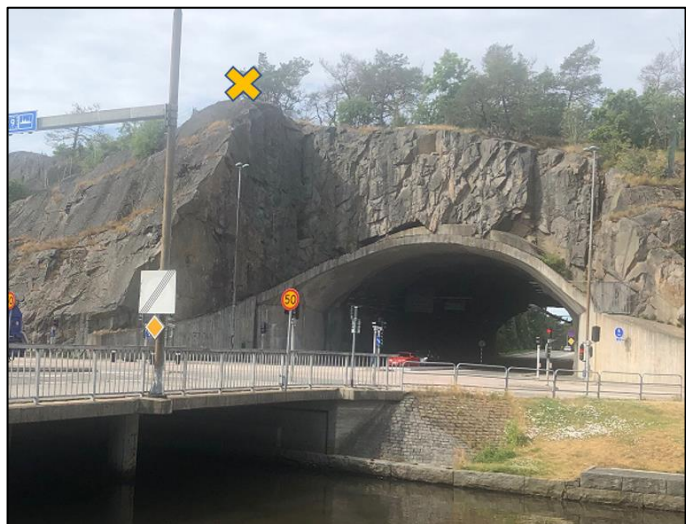
Bild 1: Hinseberget, från östra sidan
