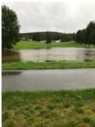
Födröjningsmagasin för dagvattennätet i Smedjebacken. Foto: WBAB WessmanBarken Vatten & Återvinning AB
