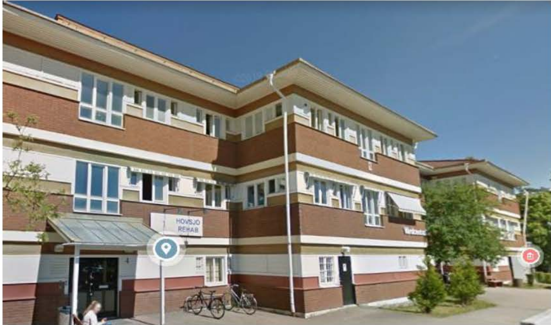
Bild 3. Vy från framsidan och den angreppsväg som initialt användes av Södertälje och senare av Botkyrka.
