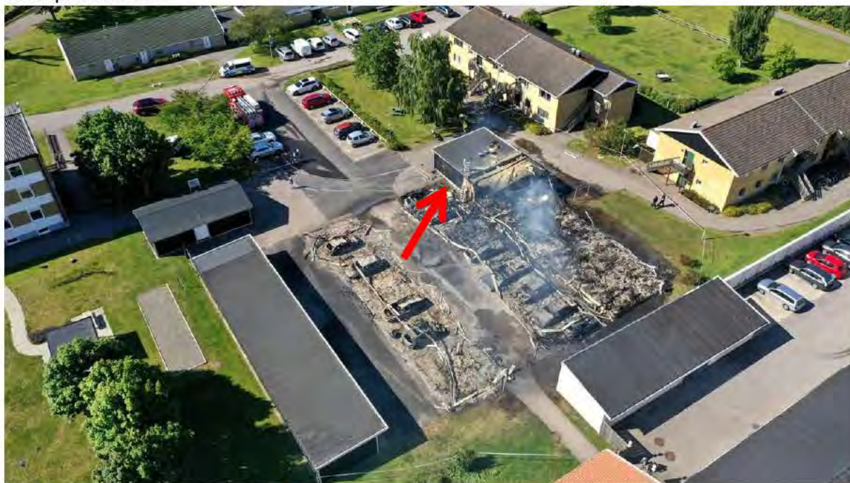
Foto: Helmuth Petersson. Pilen pekar på fjärrvärmecentral och tvättstuga.
