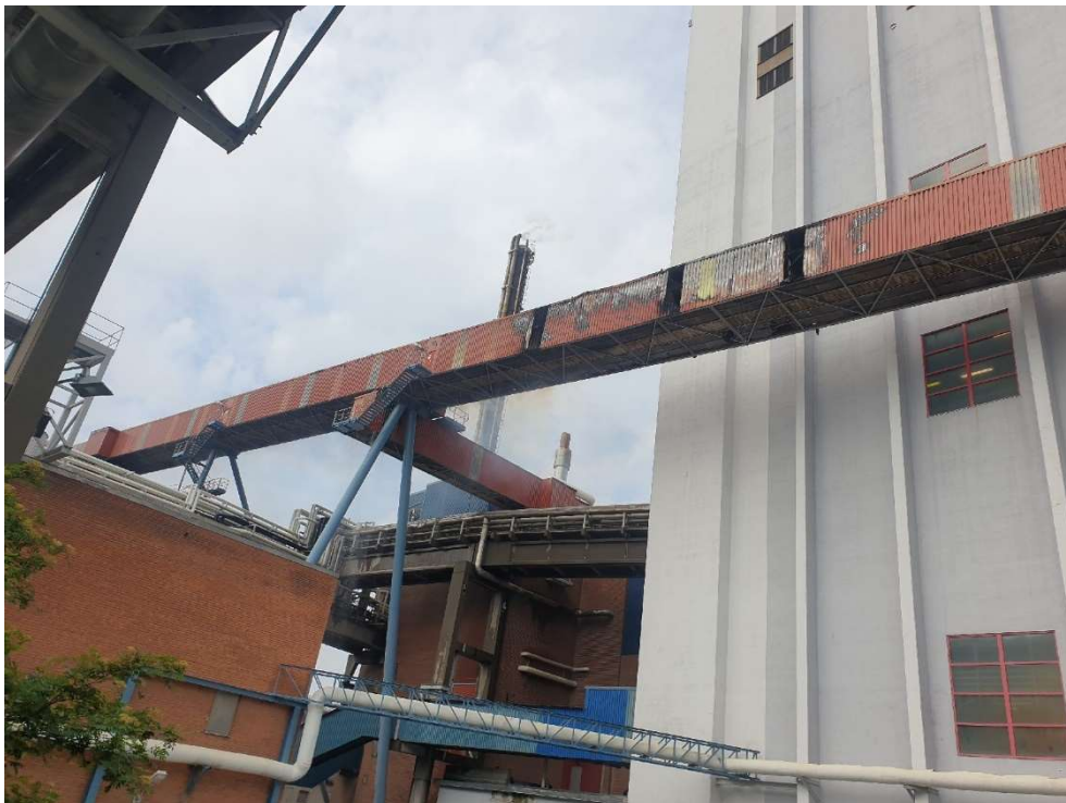
Bild 2: I andra änden är transportören 40-60 meter över marken och konstruktionen är i stål och plåt.
