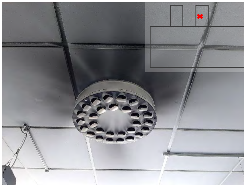
Figur 9: Bild på ventilationsdon i kontorslokal på plan 2. Samtliga ventilationsdon i den flygel där bilden är tagen såg ut som donet på bilden. Det röda krysset visar ungefärlig plats där bilden är tagen.
