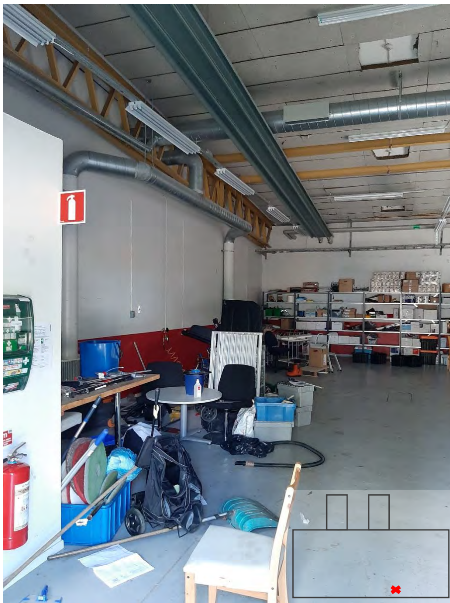
Figur 14: Bild från plan 1 på den sida av brandcellsgränsen som inte var brandutsatt (██████ lokaler). Räddningstjänstens åtgärder har varit effektiva för att rädda denna del av byggnaden. Det röda krysset visar ungefärlig plats där bilden är tagen.
