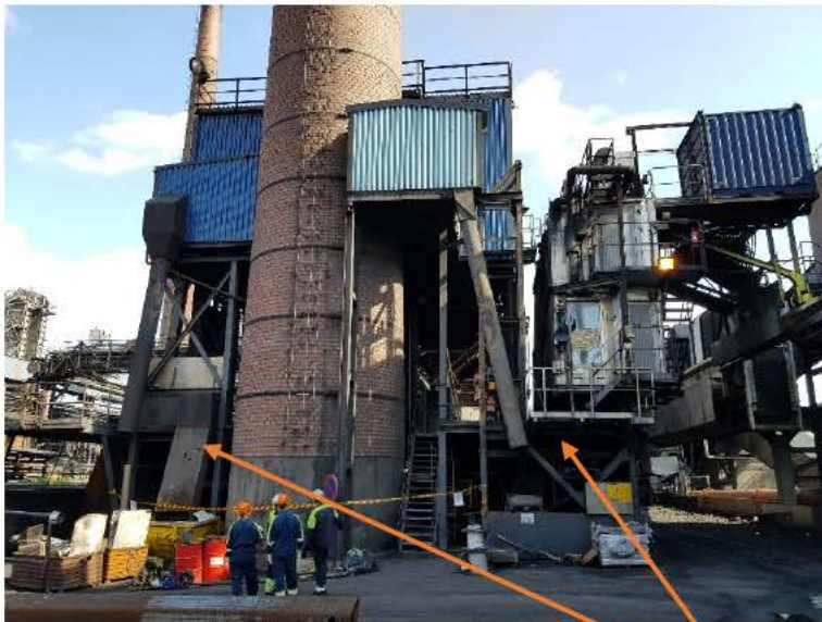
Gaveln på byggnaden. Det brann ur två olika rör.
