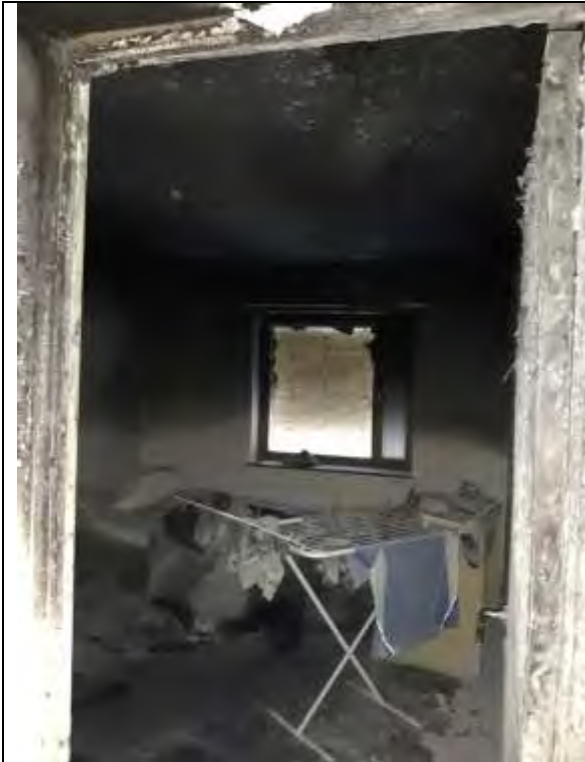
Figur 9: Foto på sovrummet inifrån. Här syntes tydliga spår från pulversläckning. Notera de opåverkade hängande kläderna samt sängen.
