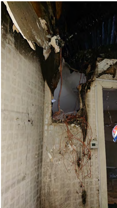
I brandskadat område i lägenhet där elskåp suttit
