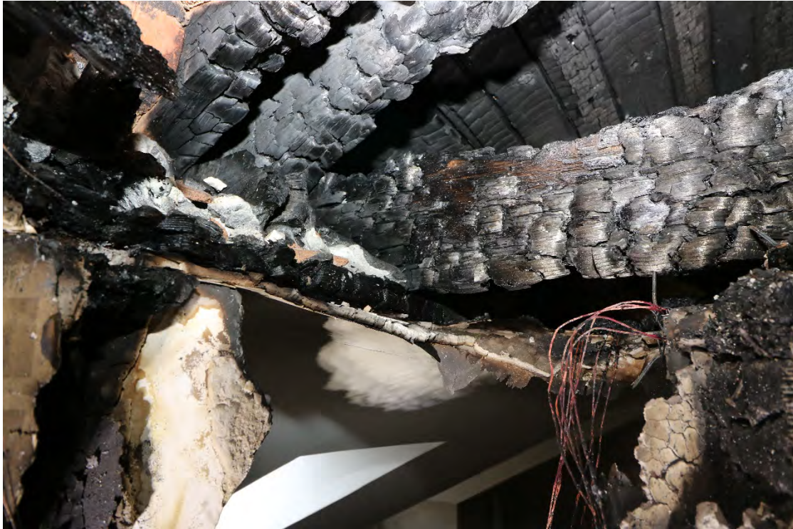
3Spridning i takstol och råspont precis ovanför elskåp
