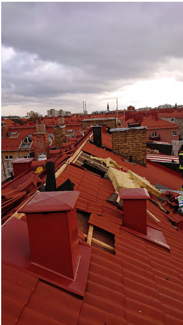
5 Visar tak med ventilationshuvar från vind och friskluftsintag till lägenheter
