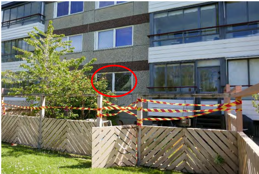
Foto 2, byggnadens baksida, köksfönster markerade med röd cirkel
