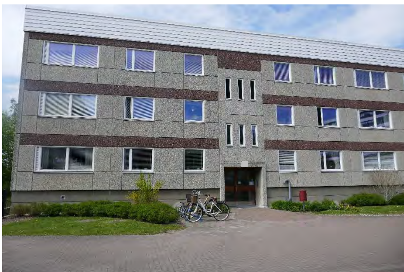
Foto 1, byggnadens framsida. Den aktuella lägenheten har inga fönster åt detta håll.
