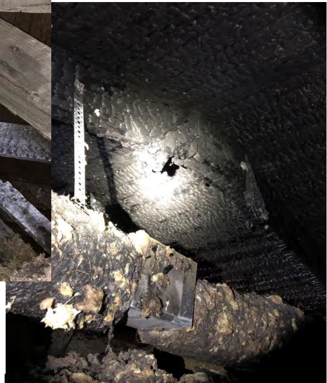
Bilder: 2019-01-21. Brandskadat vindsutrymme (västra byggnadskroppen) med flera takstolar avbrunna.
