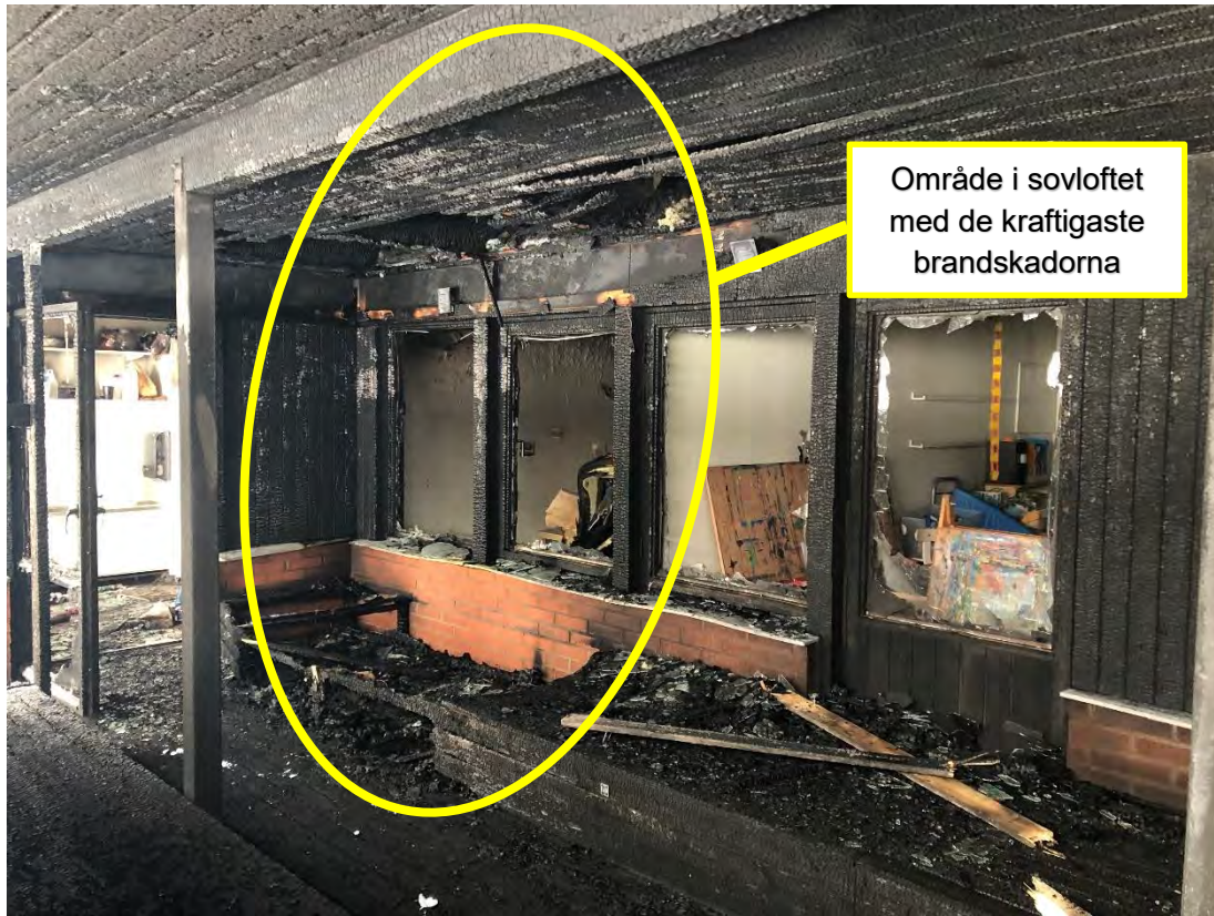
Bild: 2019-01-21. Sovloftet, med brandskador på i princip alla trätytor invändigt. Inringat område är kraftigast brandskadat, med träbänk och takpanel helt bortbränt.
