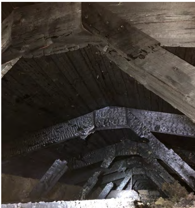
Bilder: 2019-01-21. Brandskadat vindsutrymme (västra byggnadskroppen) med flera takstolar avbrunna.
