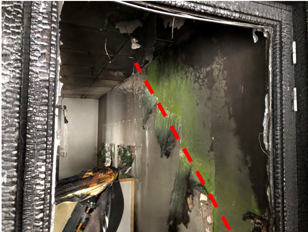
Bild: 2019-01-21. Trasigt fönster och rummet innanför, fotat utifrån sovloftets kraftigast brandskadade del. Brand-V markerat i bilden.
