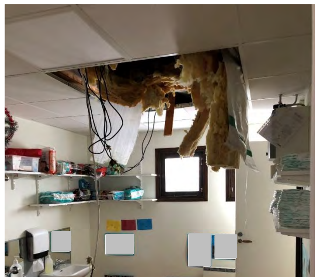
Bild: Invändig håltagning i innertak gjordes på ett antal ställen.
