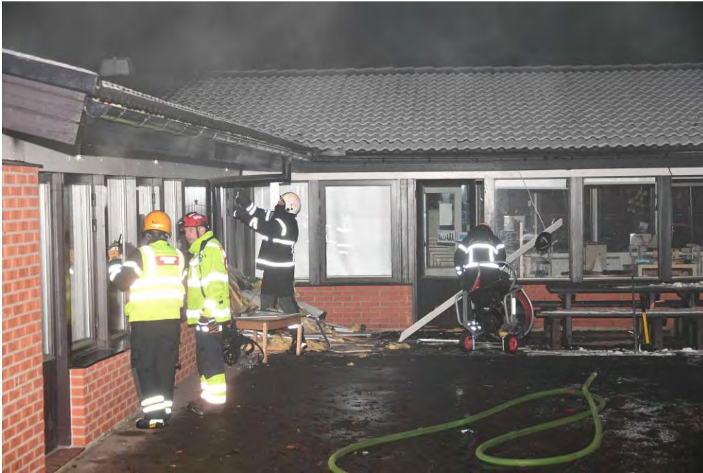
Bild: Begränsningslinje mellan västra byggnadskroppen och mellanskeppet. Delar av takfot revs för att kontrollera spridning av brand och brandgaser, i övrigt gjordes allt arbete invändigt i byggnaden.
