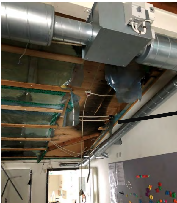
Bild: 2019-01-21. Avskiljande konstruktion hela vägen upp tillnock där mellanskeppets tak ansluter till västra byggnadskroppen.
