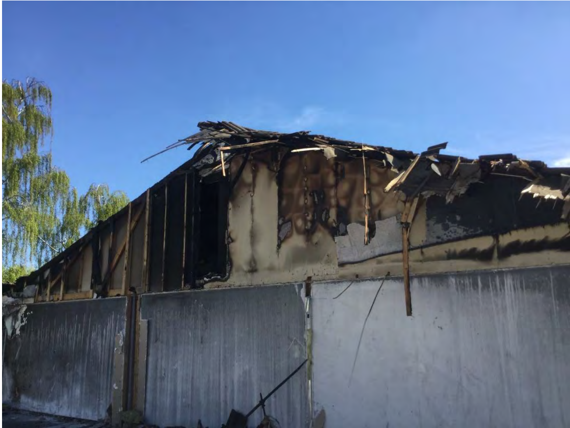
Foto 3 visar den vägg som är kvar efter att avgrävning skedde
