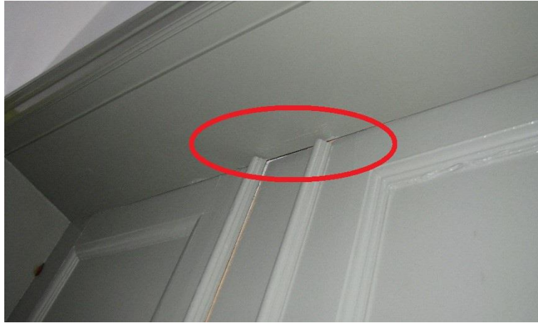
Foto 4&5. Lägenhetsdörr som vetter mot trapphus är otät i ovankant.
