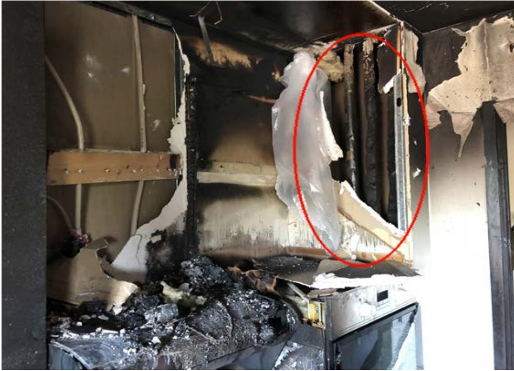
Genombränning i ventilationschaktet.
