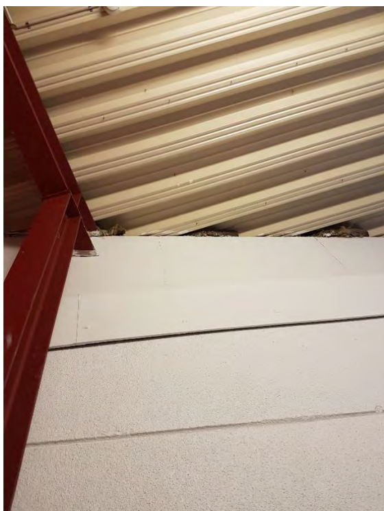
Figur 4. Anslutning yttertak/vägg mot trapphus.
