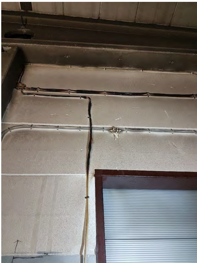
Figur 7. Brandgaslagret har gått ner till ovankant av de klassade portarna.
