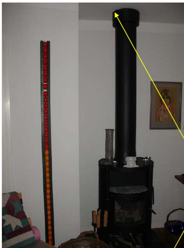
Bild 5. Skorstensgenomföringen i tvillinghuslägenheten.
