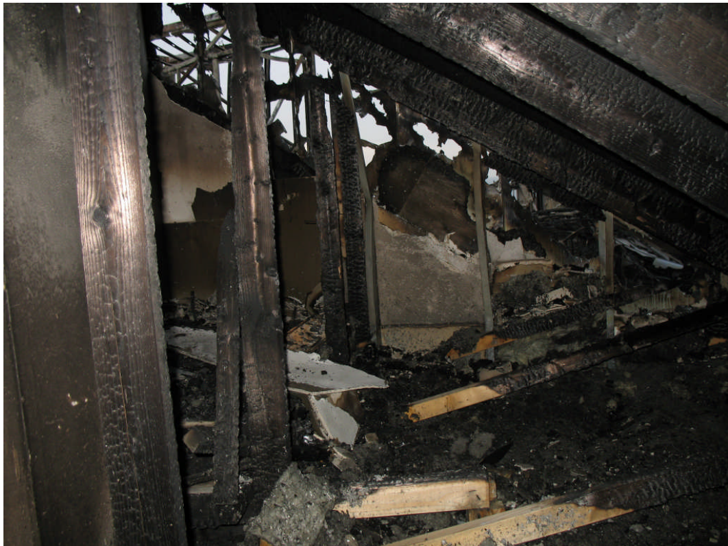
Bild 10. Vindsutrymmet från hus B(5) mot sektioneringsväggen.
