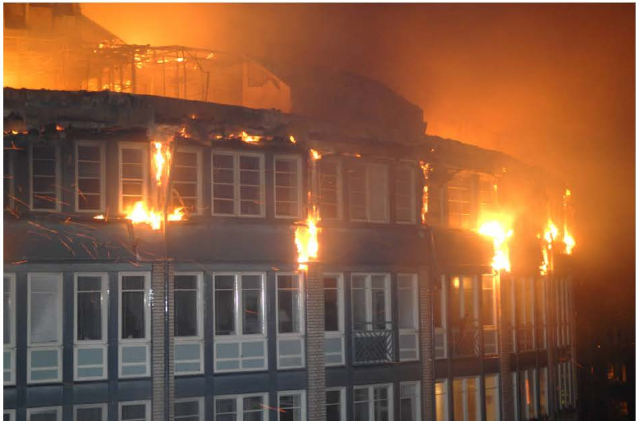
Bild 12. Zinkplåten brinner med brandspridning neråt.
