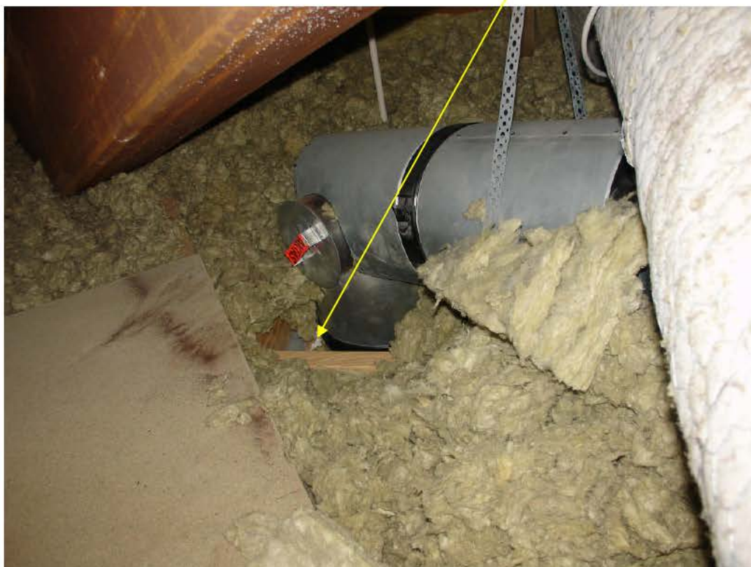
Bild 6. Skorstensgenomföring från vind, ovan lägenhet.
