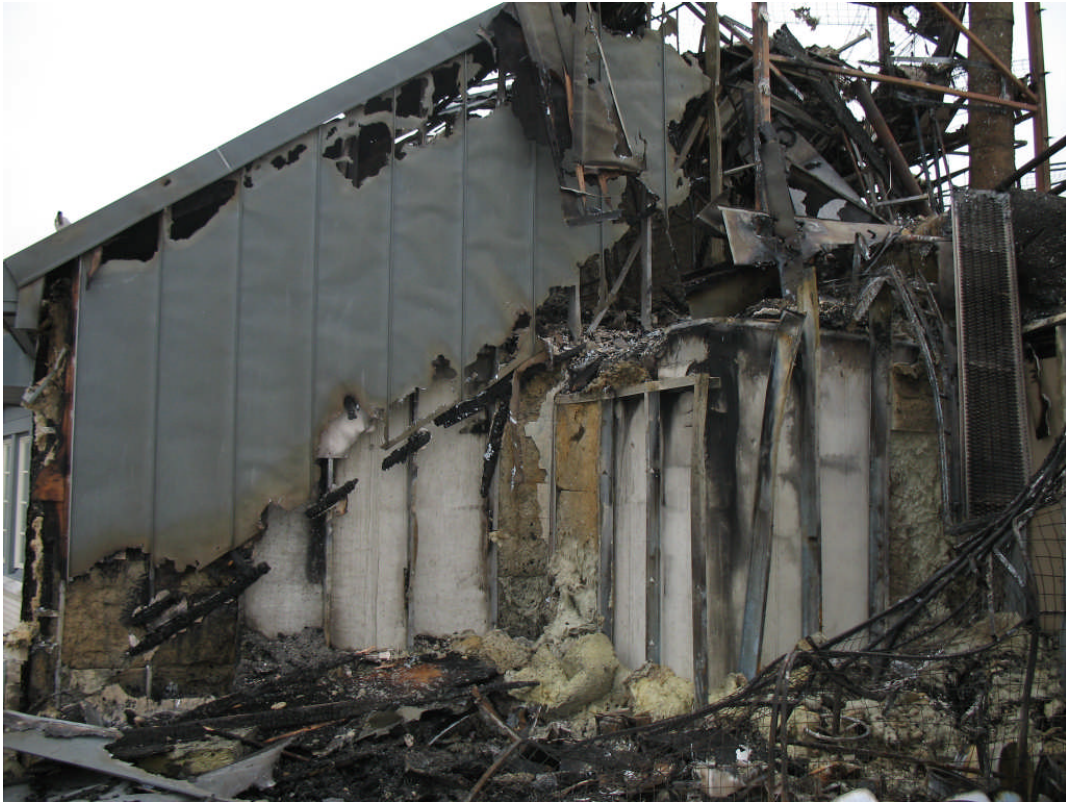
Bild 9. Sektioneringsväggen mellan hus A(3) och B(5), tagen från vinden hus A(3).
