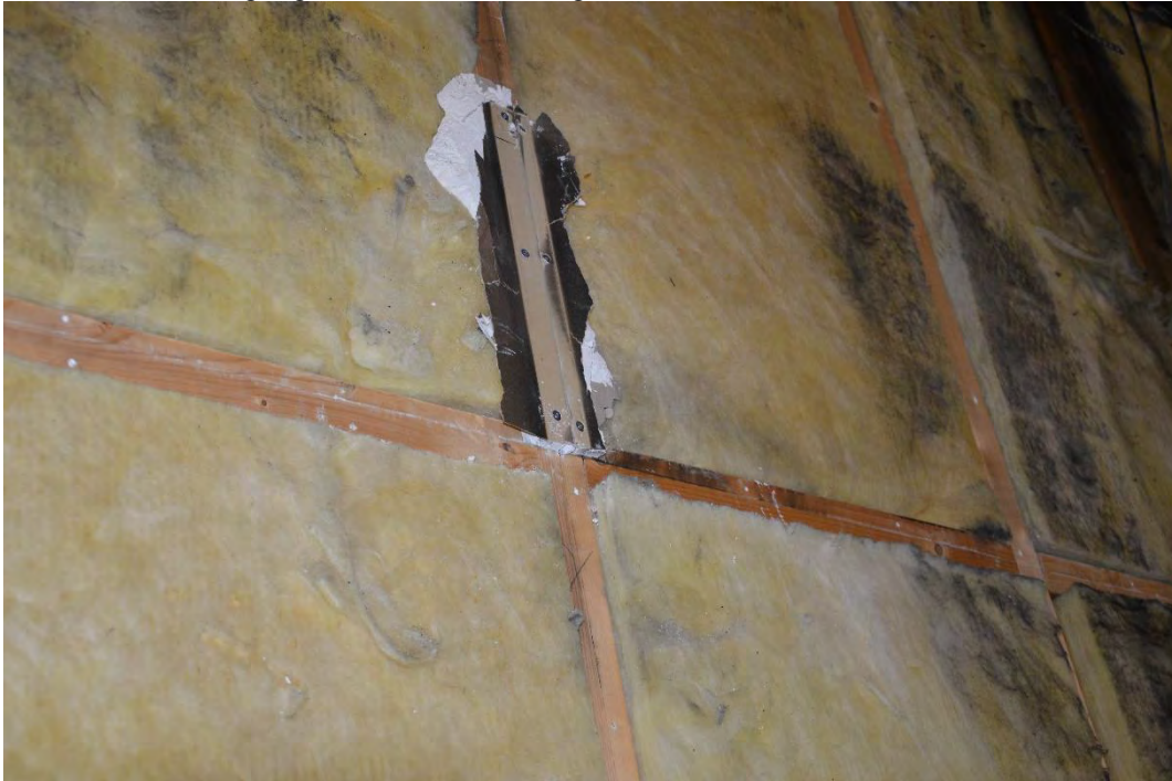
Figur 9. Bild på vägg i brandcellsgräns mellan förbindelsegång och butik. 13
