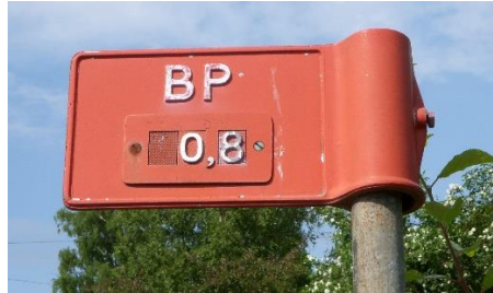
Bild 3: Flagga som visar en brandposts position.
