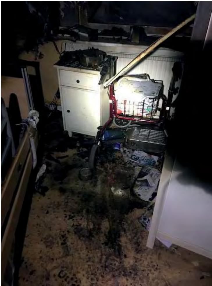
Figur 2 Brand- och rökskador i sovrum
