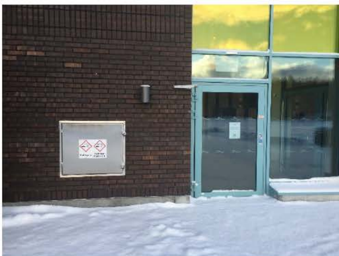
Bild 3 - 4. Lossningsplatsens position i fasad. Lossningsplatsen vid tidpunkten för händelsen med slang för natriumhypoklorit kopplad. På rör för Saltsyra är adapter påmonterad. En förberedande åtgärd då lossningsslang för kemikalierna har samma dimension, men rören vid lossningsplatsen i utförandet, har olika dimensioner 2 .
