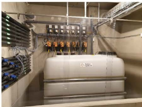
Bild 6 (Enköpings kommun). Tank för natriumhypoklorit, bild tagen från dörröppning där P1 står under lossningsförloppet. Bild 7. Tankrummets frånluft och gasindikator markerade.
