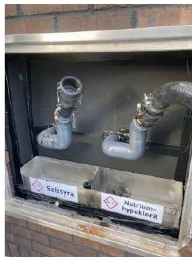
Bild 3 - 4. Lossningsplatsens position i fasad. Lossningsplatsen vid tidpunkten för händelsen med slang för natriumhypoklorit kopplad. På rör för Saltsyra är adapter påmonterad. En förberedande åtgärd då lossningsslang för kemikalierna har samma dimension, men rören vid lossningsplatsen i utförandet, har olika dimensioner 2 .
