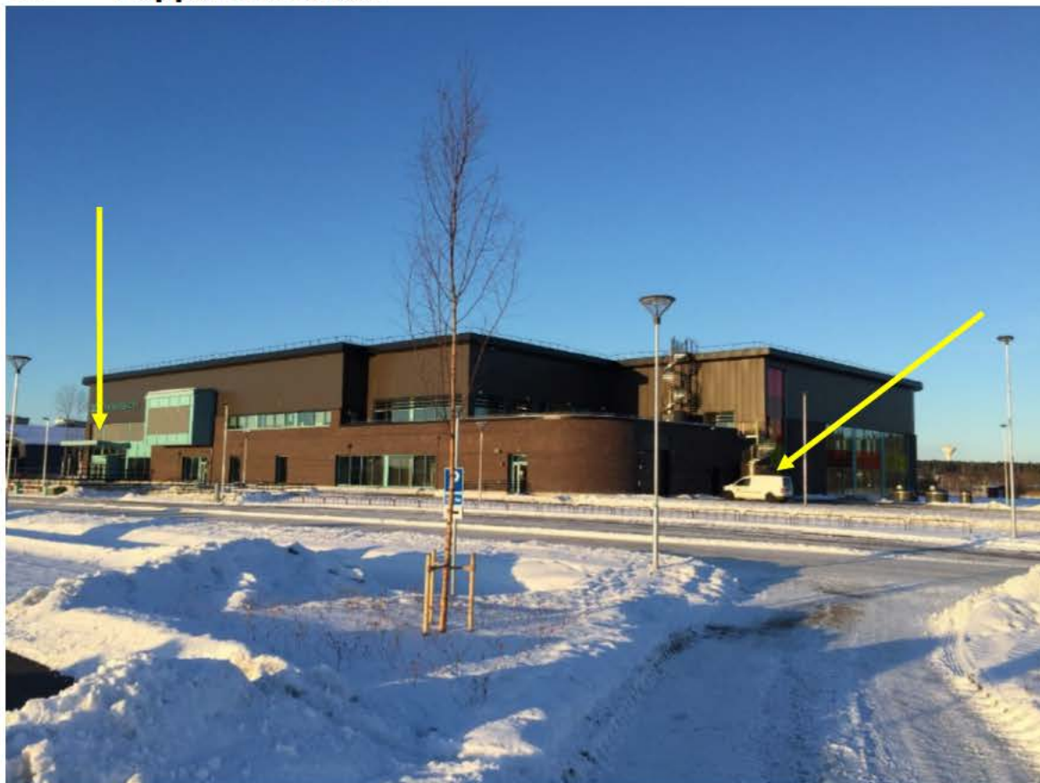
Bild 1. Pepparrotsbadet. Huvudentré på byggnaden till vänster i bild samt plats för olyckan, byggnadens södra gavel till höger i bild markerade.
