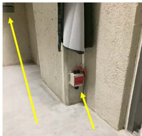
Bild 6 (Enköpings kommun). Tank för natriumhypoklorit, bild tagen från dörröppning där P1 står under lossningsförloppet. Bild 7. Tankrummets frånluft och gasindikator markerade.
