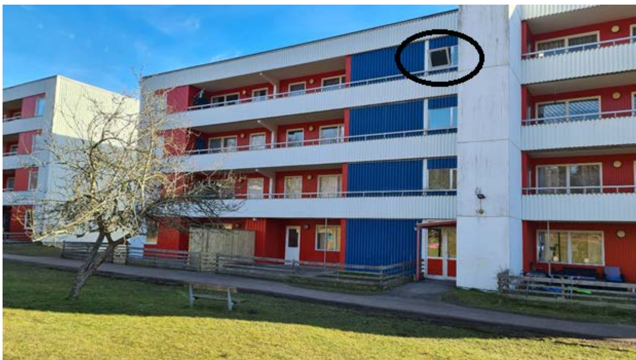
Byggnadens baksida med loftgångar och trapphus. Högst upp syns fönstret som öppnas automatiskt vid brand.
