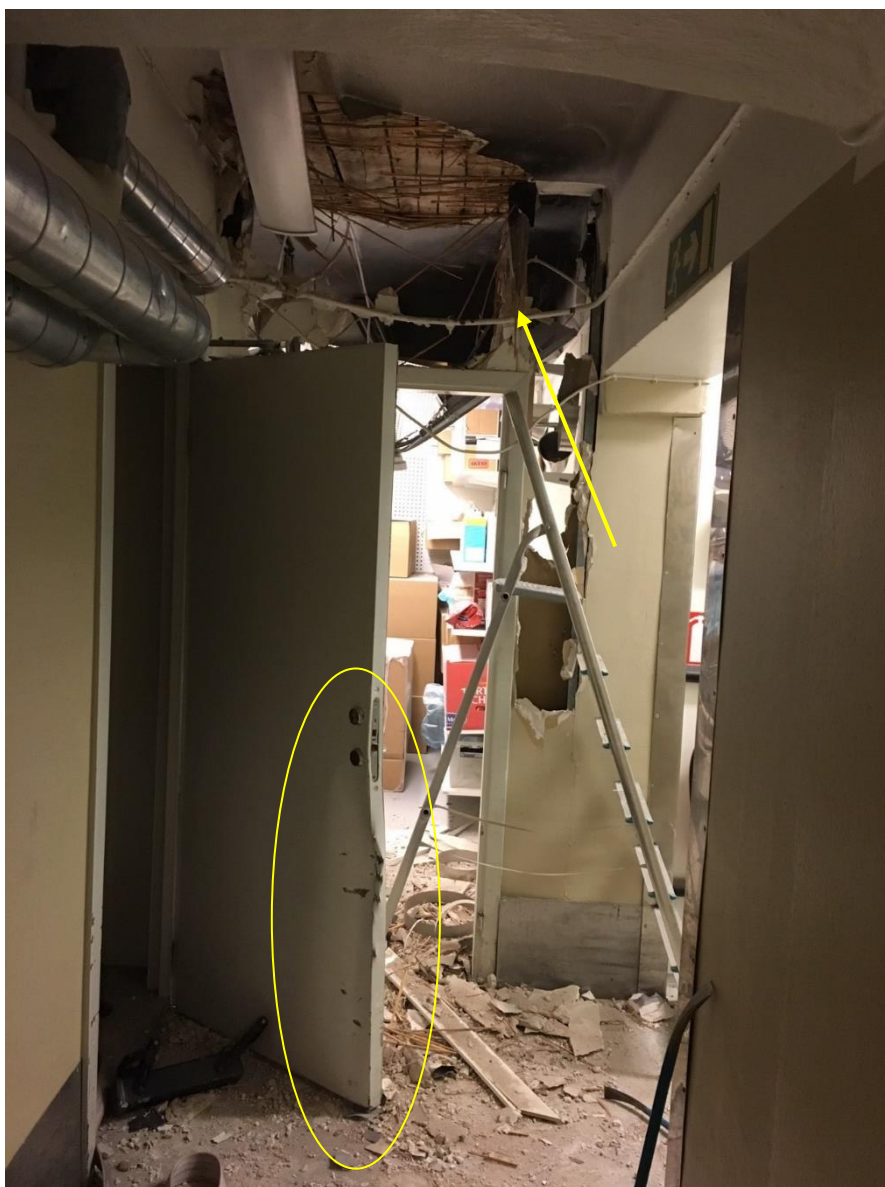
Bild 2. El-dosans position märken på dörr efter forcering med "Donken" markerade.
